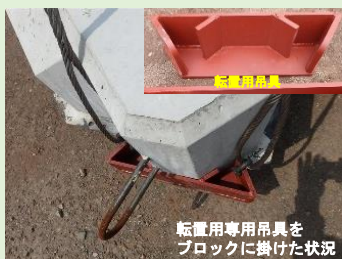
吊り上げる際には、製品の「欠け」に注意して下さい。
