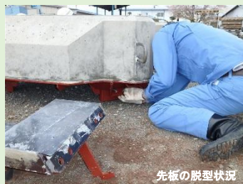
先板の脱型状況
