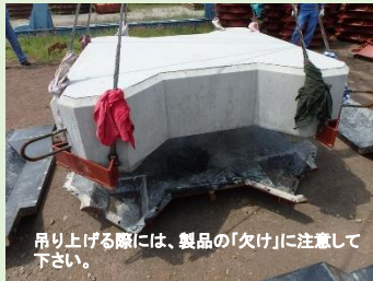
転置用専用吊具をブロックに掛けた状況
