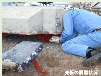
先板の脱型状況
