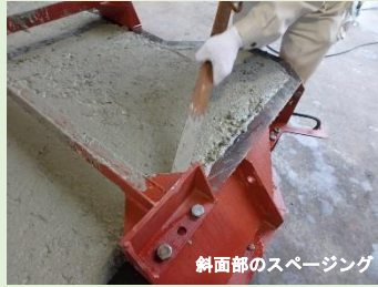
斜面部のスページング
