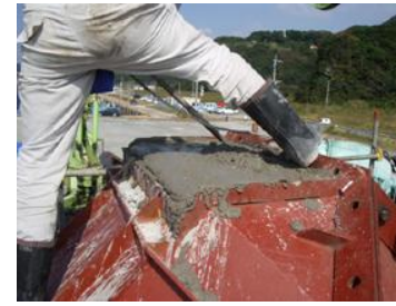
打設口部スペーシング
