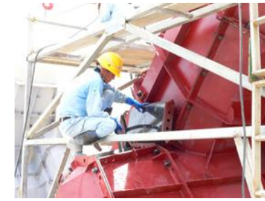
袖部コテ均し
