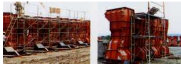
打設用足場使用例
